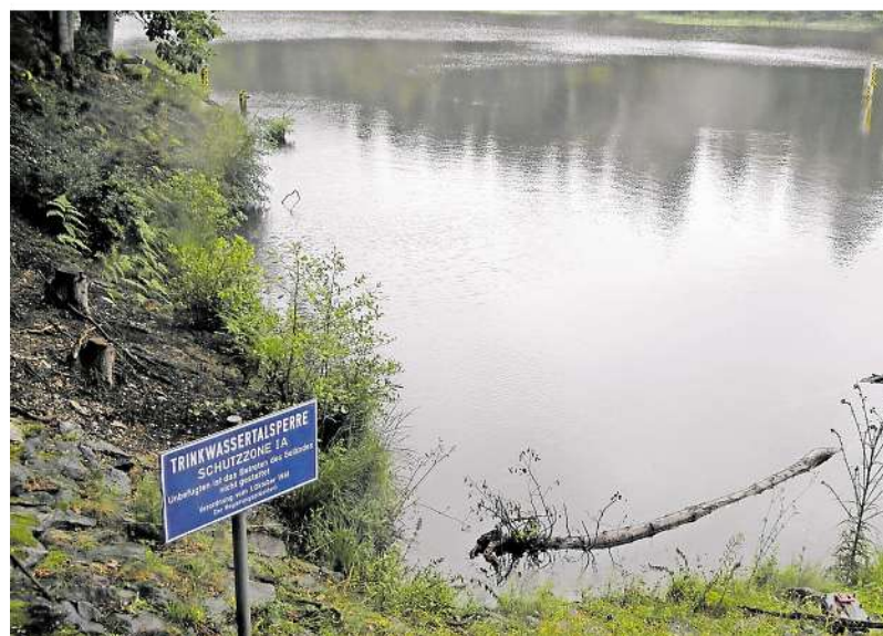
Die Dreilägerbachtalsperre soll ihre reine Trinkwasserfunktion behalten, fordert Geschäftsführer Walter Dautzenberg. Hier ein Blick auf das Vorbecken der Talsperre.
